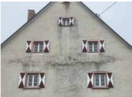
Bild 12: Putzaufwölbung im oberen Bereich mit einem darunterliegenden, durch Holzfäule stark zerstörten Querbalken.
