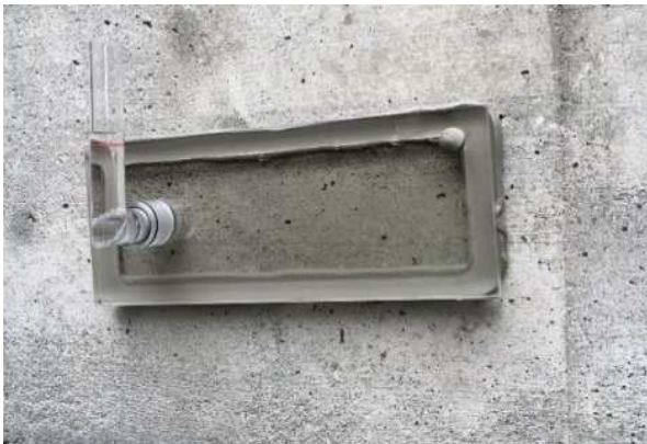
Messung der Wasseraufnahme an einer Fassade
