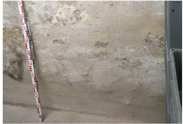
Entnahme von Salzproben für die Analyse
