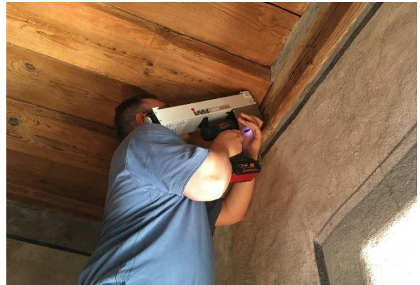
Bohrwiderstandsmessung an einem Holzbalkenkopf
