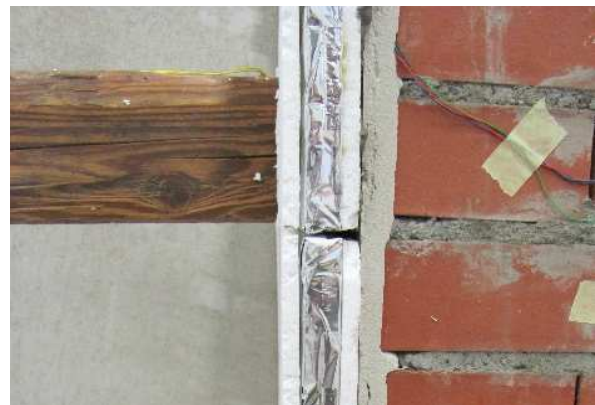
Entwicklung und Bau von Demonstratoren
