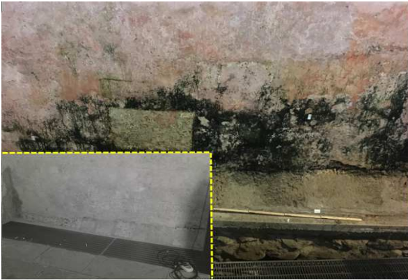
Der Farbstoff in den Algen wird bei der NIR Fotografie transparent (Untergrund wird sichtbar)
